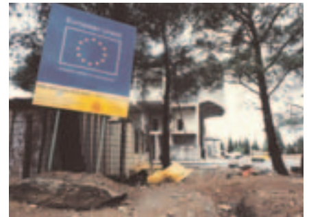
Bygging av brannstasjon i Serbia finansiert av EuropeAid
